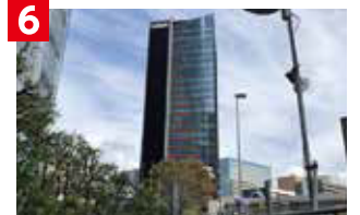
6 左手に電通本社ビル、正面に住友不動産汐留浜離宮ビルが見えます。
